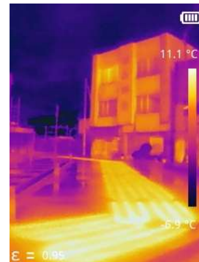
高熱伝導コンクリート放熱状況 2024.12.12
