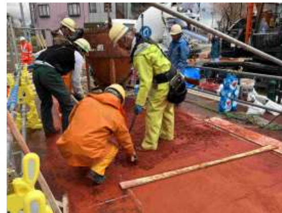
高熱伝導コンクリート打設状況 (意匠上、着色しています)
